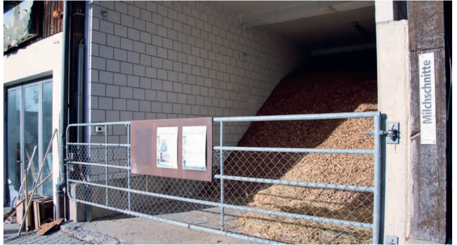
Die moderne und vollautomatische Holzschrotzelheizung, die alle Gebäude des Betriebs beheizt, wird mit dem eigenen Holz versorgt.
